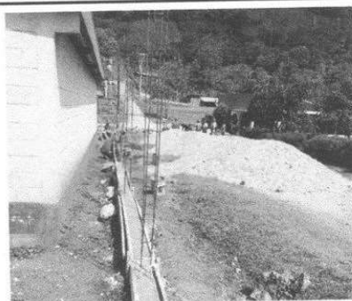
Foto 5: Se observa la colocación de la base del muro perimetral
