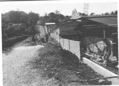
Foto 1: Se observa que los señores están trabajando para la construcción de muro perimetral.
