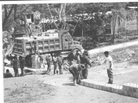
Foto 4: Se observa que los señores están descargando los materiales para la construcción del muro perimetral.
